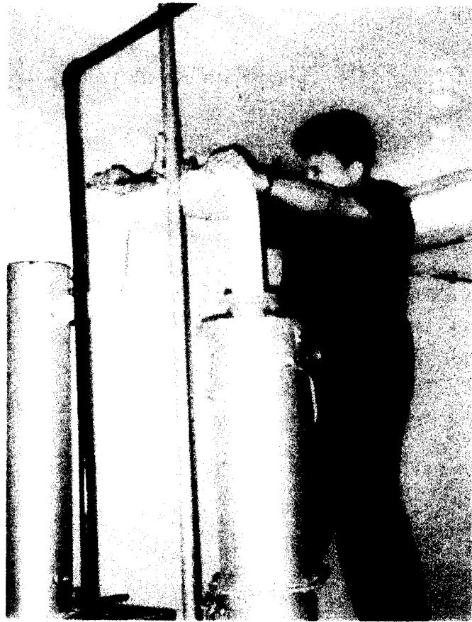
รูปที่ 103. การติดตั้งวาล์วนิรภัย (safety valve) ด้านบนสุดของหม้อต้มน้ำ.
