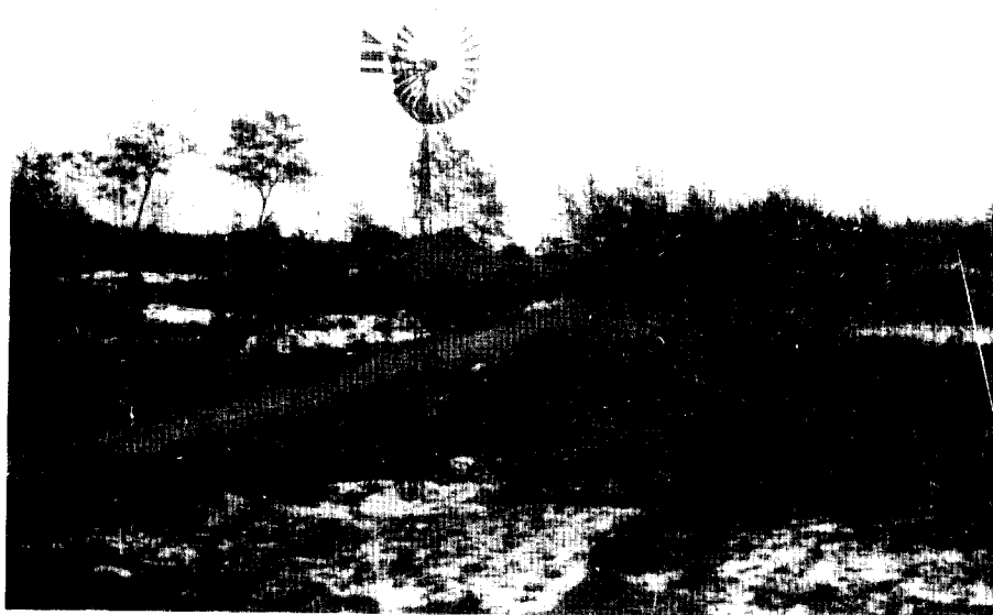
รูปที่ 7. กังหันลมเพื่อนำน้ำจืดใต้ดิน ขนาดเส้นผ่าศูนย์กลาง ของกังหันลม 14 ฟุต .
