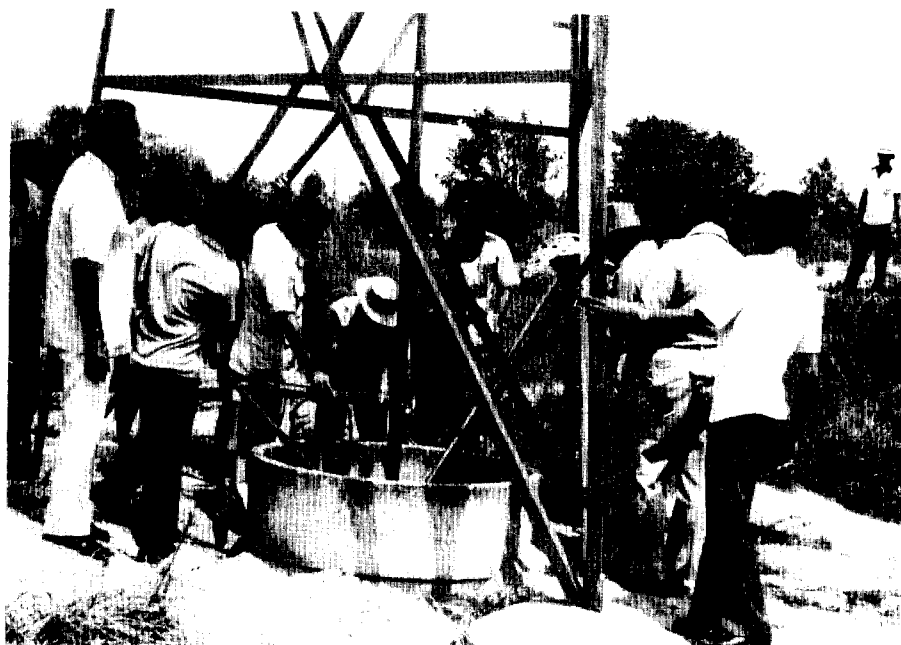
รูปที่ 8. บ่อน้ำใต้ดิน ลึก 6 เมตร .
