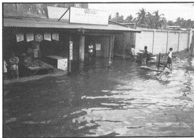
สภาพน้ำท่วมประจำที่รอการแก้ไขในปัจจุบัน REGULAR FLOODING AWAITING TIMELY MITIGATION
