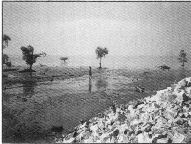
๖๕ ที่ตั้งประตูระบายน้ำหัวลำพู
