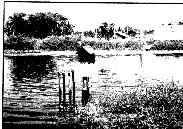
เครื่องวัดระดับน้ำอัตโนมัติที่คลองชายทะเล STAGE RECORDER INSTALLED AT KLONG CHAI THALE
