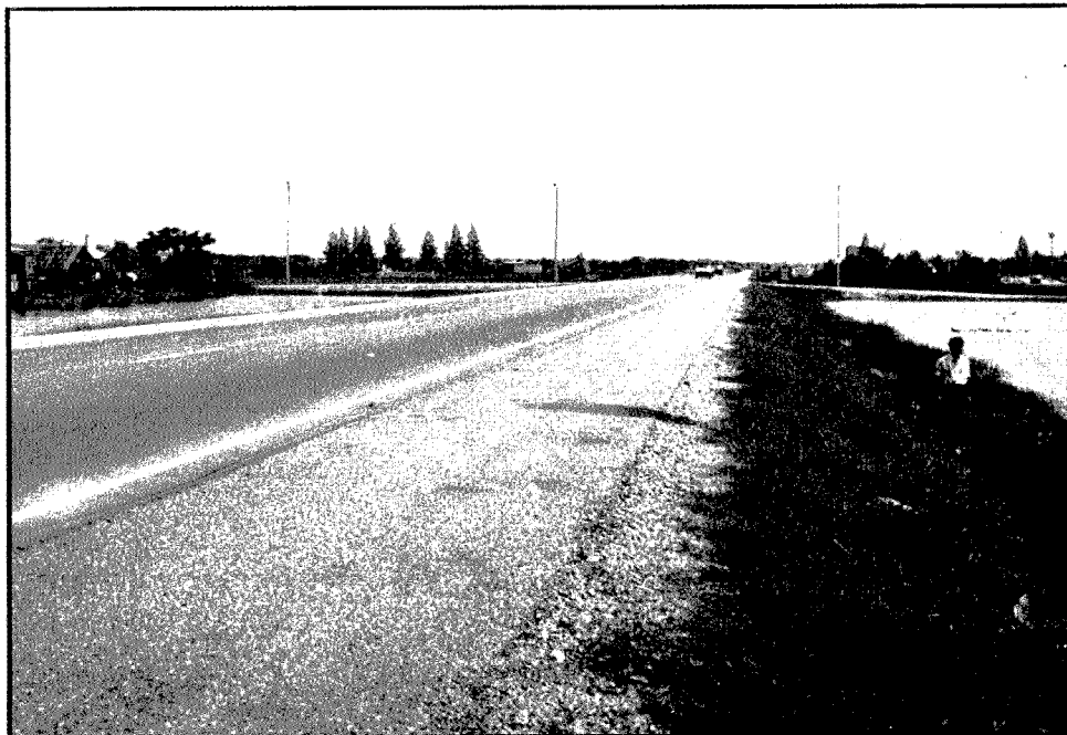
ถนนศรีนครินทร์มีระดับสูงพอเพียงสำหรับเป็นคันกั้นน้ำชั้นใน SRINAKHARIN ROAD HAVING ADEQUATE ELEVATION FOR SERVING AS THE INNER FLOOD BARRIER
