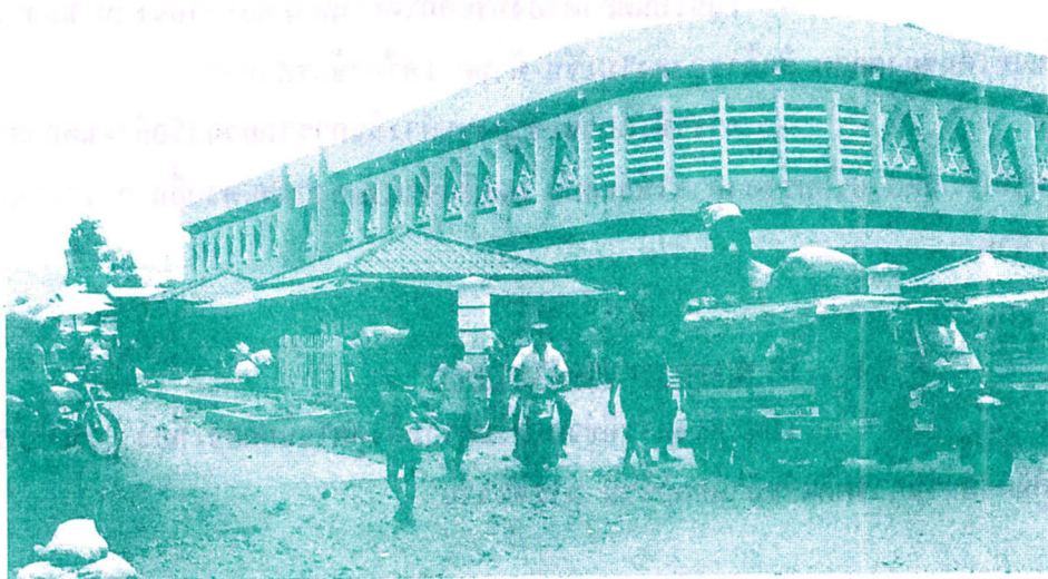
สภาพบริเวณด้านหน้าอาคารตลาดเช้า ควรปรับปรุง บริเวณที่จอดรถ และการรักษาความสะอาด
