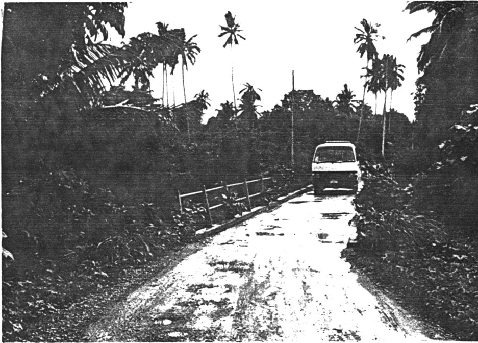
รูปที่ ๒.๑๗ ถนนสายหลักและสะพานข้ามคลองปึงหลาที่คับแคบ
