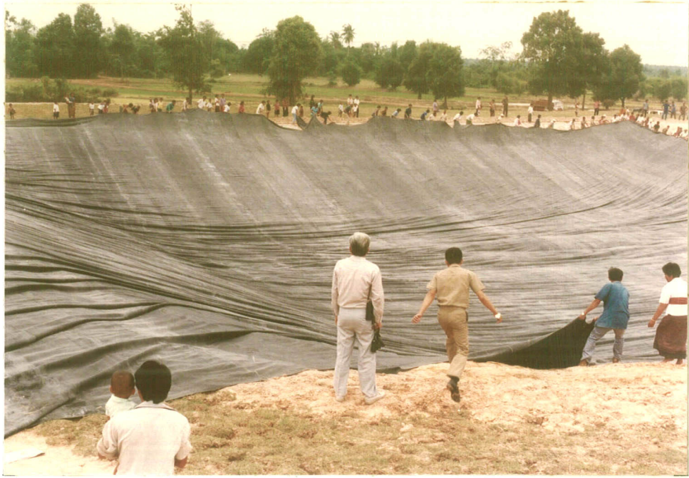
การใช้แผ่นยางรองบ่อน้ำ
