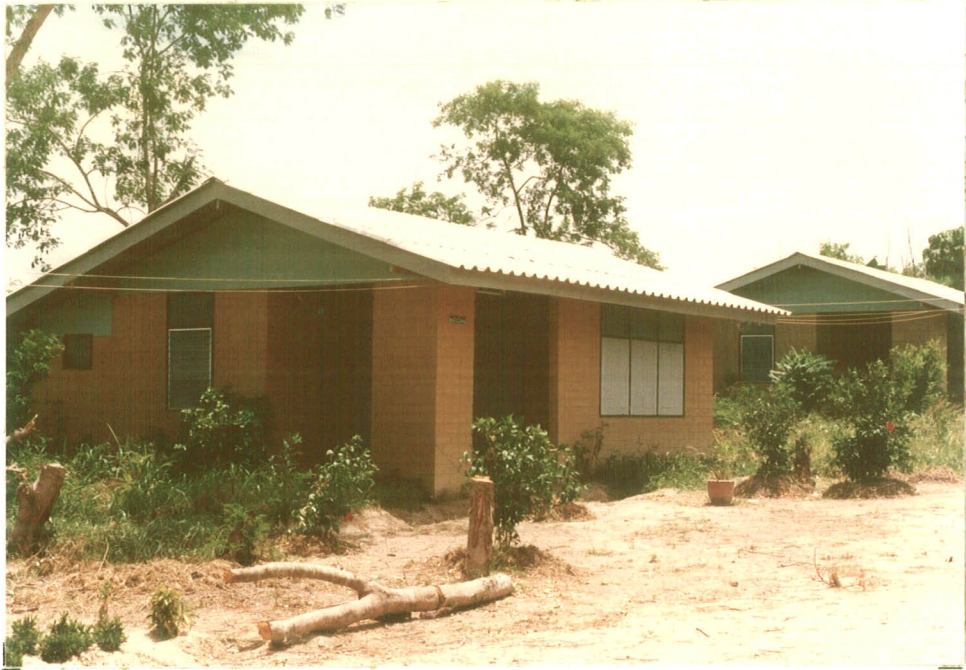
วิจัย-พัฒนาอิฐดินซีเมนต์ เพื่อก่อสร้างอาคาร
