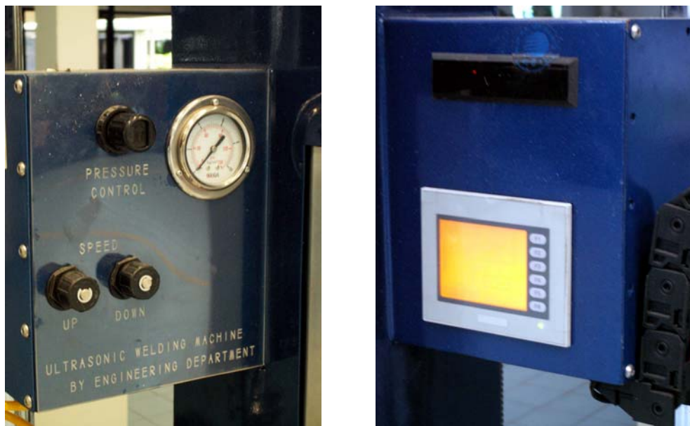
รูปที่ 8. การติดตั้งอุปกรณ์ควบคุมนิวเมติกและอุปกรณ์ PLC.
