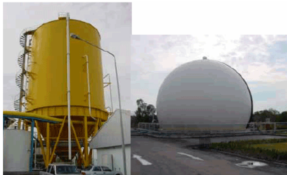
รูปที่ 15. ถังย่อยสลายแบบไม่ใช้ออกซิเจนและถังเก็บก๊าซชีวภาพ โครงการผลิตปุ๋ยอินทรีย์และพลังงานจังหวัดระยอง เทศบาลนครระยอง.
