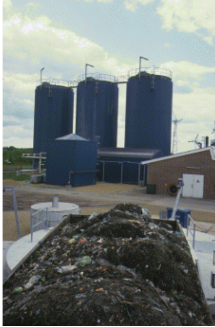
รูปที่ 14. ถังหมักแบบ Anaerobic Digestion.
