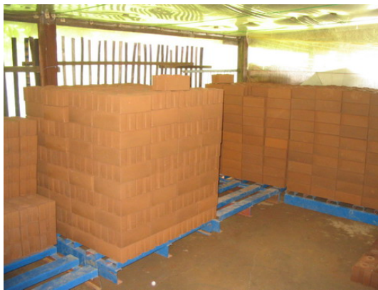
รูปที่ 19. การบ่มบล็อกประสานในโรงบ่ม.
