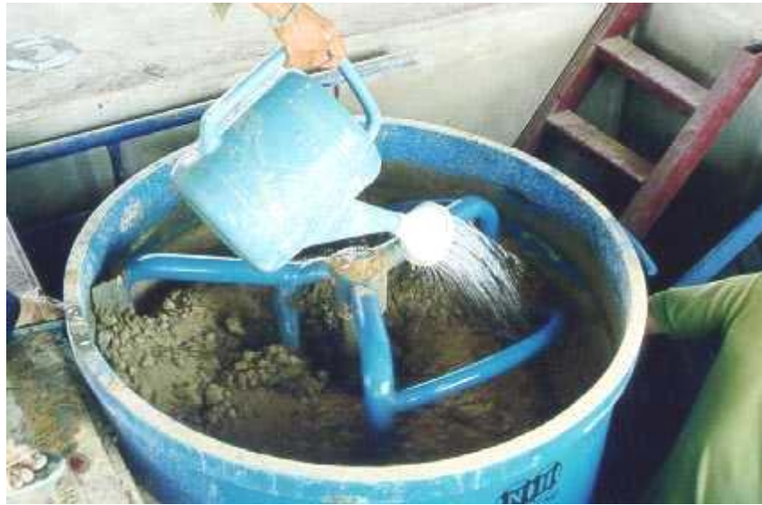
รูปที่ 13. การเติมน้ำลงในส่วนผสมโดยใช้บัวรดน้ำ.
