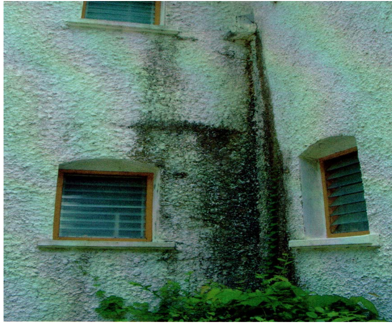
รูปที่ 10. การเจริญเติบโตของสาหร่ายบนพื้นผิวของตึกที่ตั้งอยู่บริเวณใกล้เคียงกับสถานที่วางแผ่นทดสอบ.
