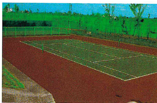
สนามเทนนิสดัดแปลงเพื่อชะลอน้ำหรือเก็บกักน้ำ
