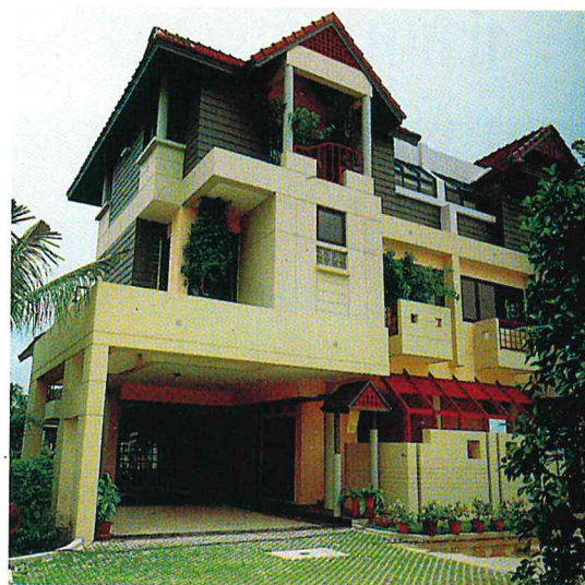
ที่เก็บน้ำใต้ดินบริเวณลานจอดรถหน้าบ้าน
