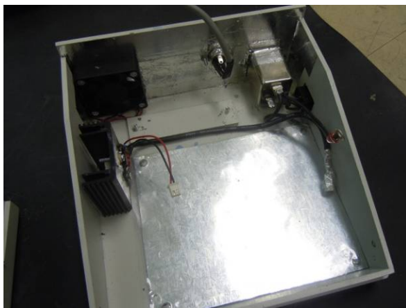
รูปที่ 3.45. การติดตั้งแผ่น ground plate ก่อนวางแผ่นวงจรไฟฟ้า (control PCB).
