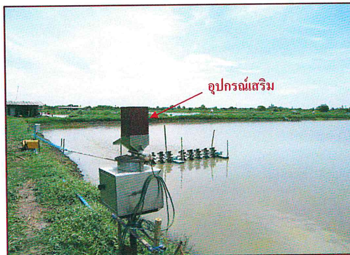
รูปที่ 20. การติดตั้งอุปกรณ์เสริม.
