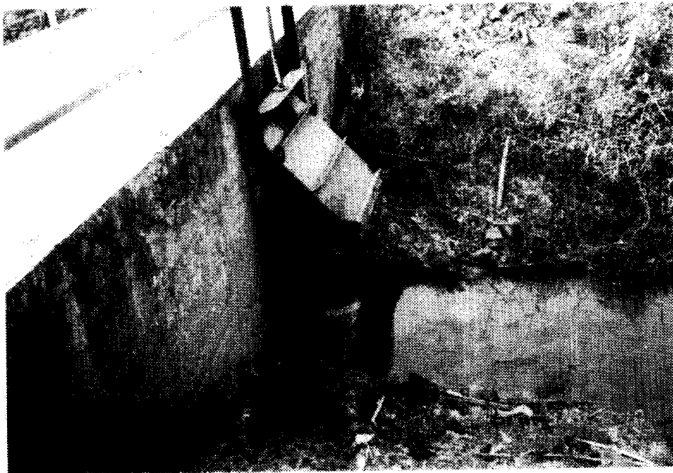
รูปที่ 8. ประตูระบายน้ำ (เขียงแบ่งน้ำ) ที่ถูกทำลายอยู่ที่สะพานข้ามลำห้วย.
