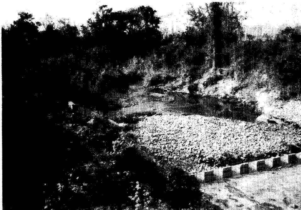
รูปที่ 2. น้ำในลำห้วยด้านหน้าฝ่าย และน้ำที่กำลังไหลออกจากท่อ เนื่องจากประตูระบายน้ำถูกทำลาย.
