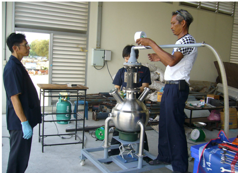
รูปที่ 2.15. การติดตั้งอุปกรณ์เครื่องกลั่นในระดับนำทาง.
