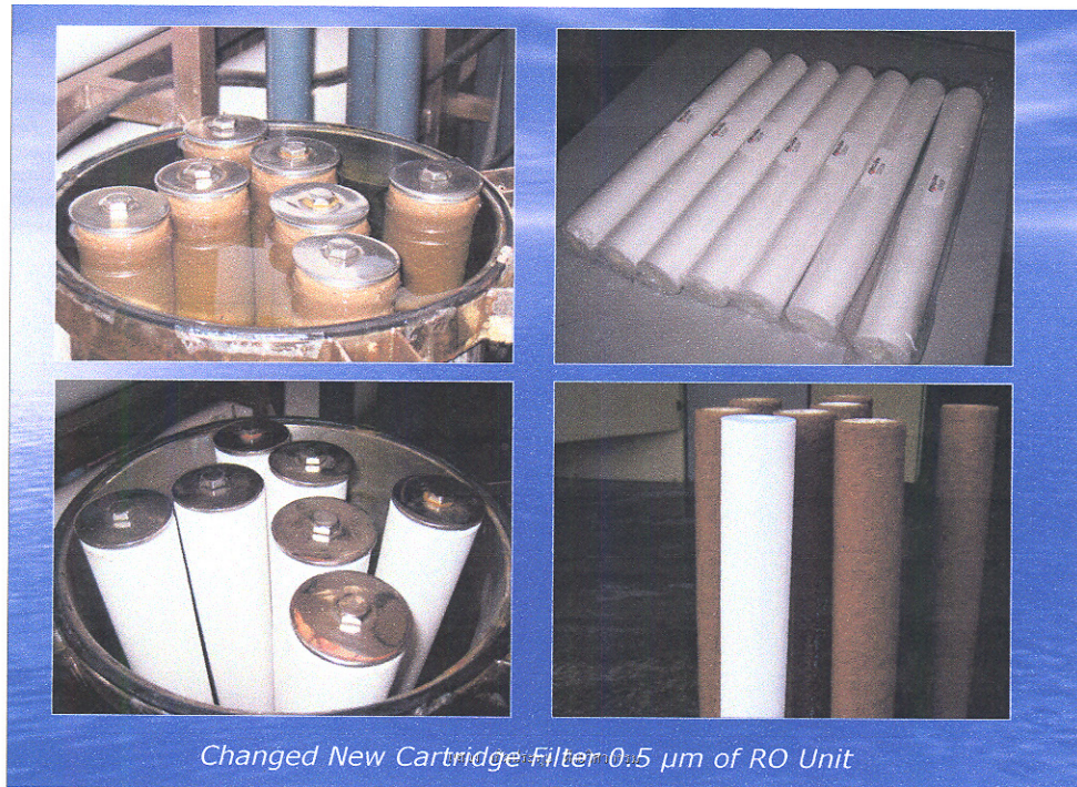
รูปที่ 16. การถอดตันของตะกอนบนไส้กรอง 5 ไมครอน.
