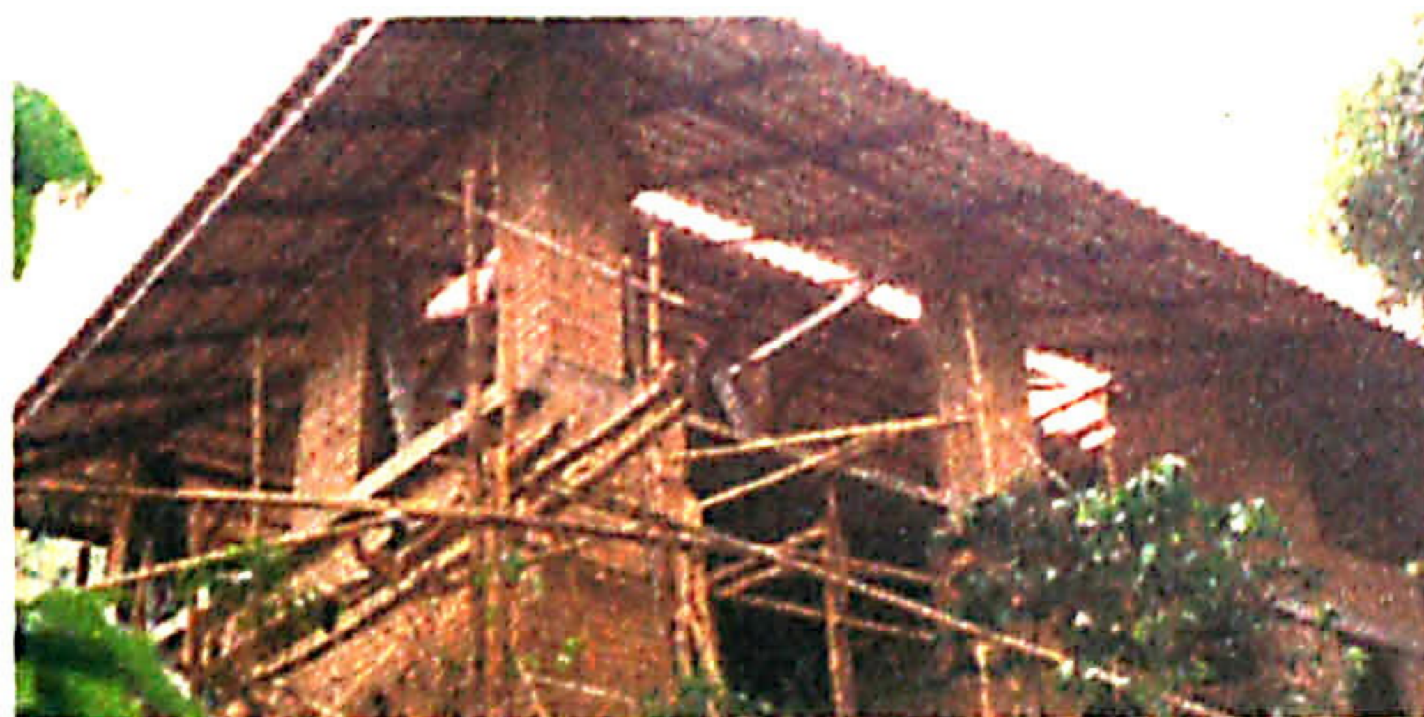
รูปที่ 2, 3 อาคารกักตบรวดู ของศูนย์ศึกษาพัฒนาปางบง ในมูลนิธิโครงการหลวงที่ใช้บล็อกประสาน วท. ก่อสร้างเพื่อการเรียนรู้ของชาวบ้าน.
