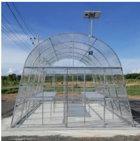
รูปที่ 4. ต้นแบบตู้อบพลังงานแสงอาทิตย์ อำเภอบ้านโฮ่ง จังหวัดลำพูน
