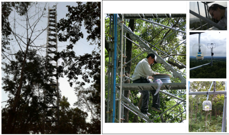
รูปที่ 6. การติดตั้งระบบการตรวจวัดปริมาณอนุภาคบนหอคอยในพื้นที่ป่า
